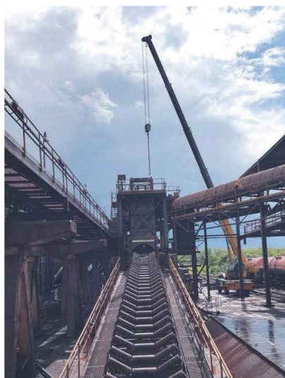
Demontáž technológie pôvodného pásu T1, separátora a Flexowella.
